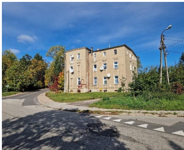
FOTOGRAFIA 12. Budynek przy ul. Kolejowej 21 przewidziany do wyburzenia
