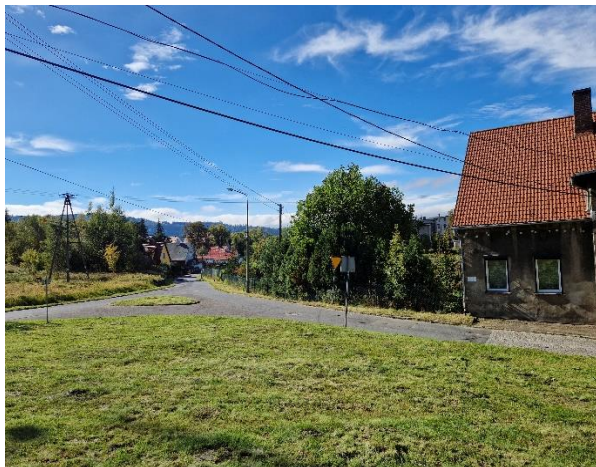
FOTOGRAFIA 17. Skrzyżowanie objęte inwestycją w rejonie budynku nr 31 ul. L. Waryńskiego w miejscu przebiegu trasy obwodnicy
