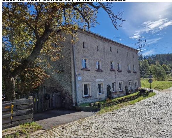
FOTOGRAFIA 16. Budynek przy ul. L. Waryńskiego nr 24 przewidziany do wyburzenia - kolizja przebiegiem obwodnicy
