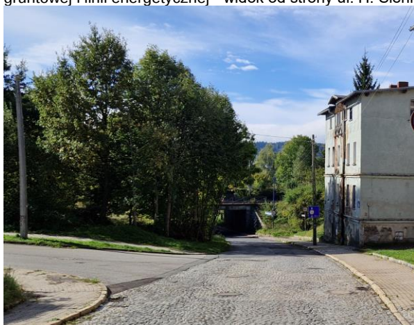
FOTOGRAFIA 7. Teren w rejonie ul. H. Sienkiewicza i ul. Dworcowej - miejsce włączenia obwodnicy i jezdni dodatkowej w teren zabudowany. W miejscu widocznego budynku powstanie wiadukt.
