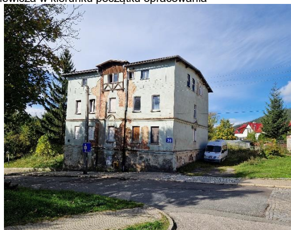
FOTOGRAFIA 8. Budynek przy ul. H. Sienkiewicza nr 28 przewidziany do wyburzenia - miejsce budowy wiaduktu, obwodnicy oraz jezdni dodatkowej
