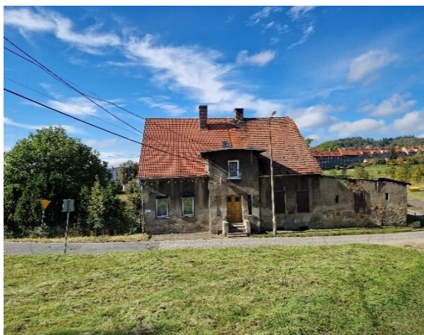
FOTOGRAFIA 15. Budynek przy ul. L. Waryńskiego nr 31 przewidziany do wyburzenia - kolizja przebiegiem obwodnicy
