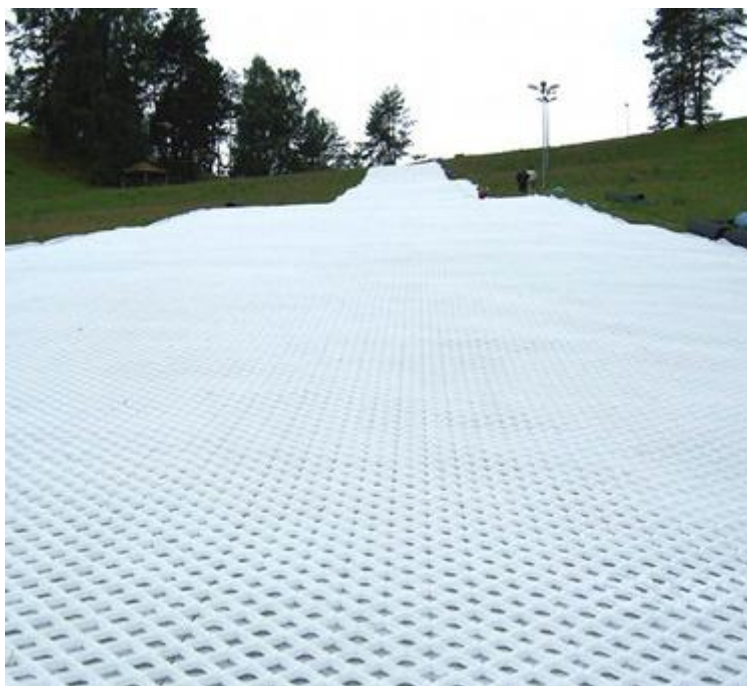
Rysunek 2. Przykładowe zagospodarowanie stoku narciarskiego poprzez wyłożenie nawierzchni białym igielitem
